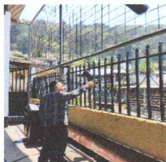
PINTURA DE BARANDAS PARTE EXTERIOR DE LA ESCUELA
