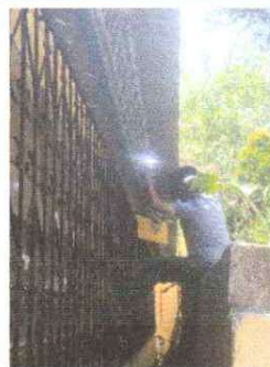
COLOCACION DE CANALES PATIO DOS DEL CENTRO EDUCATIVO
