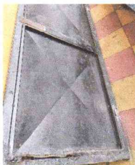
CAMBIO DE UNA PUERTA EN LOS BAÑOS DE NIÑOS PARTE INTERIOR
