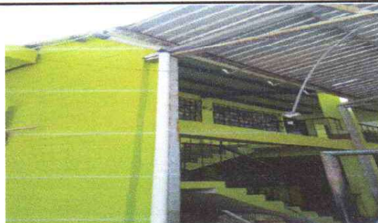
SUMINISTRO E INSTALACION DE CANAL PLUVIAL Y BAJADAS DE AGUA
