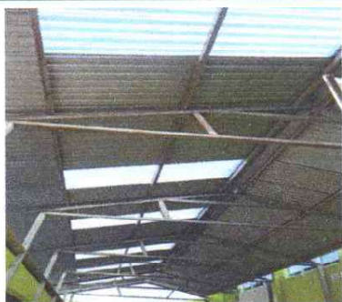
SUMINISTRO E INSTALACION DE LAMINA TRASPARENTE TROQUELADA
