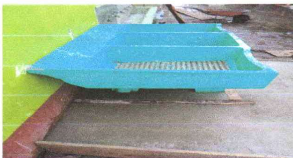
SUMINISTRO Y COLOCACION DE PILA
