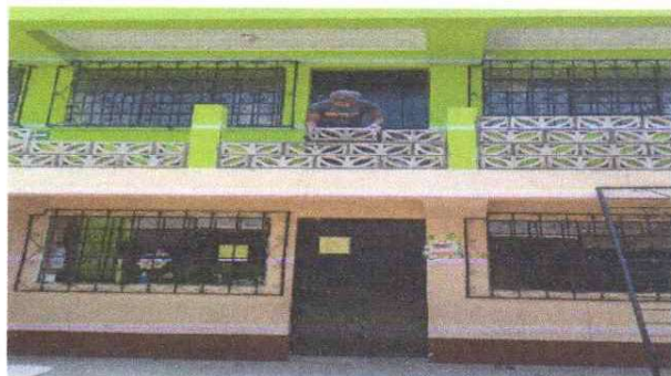
SUMINISTRO Y CONTINJACION DE PARED DE BLOCK EN BARANAS Y GRADAS
