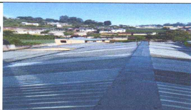
SUMINISTRO Y COLOCACION DE LAMINA TRASPARENTE TROQUELADA
