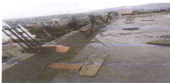
CONTORNO DE TERRAZA CON BLOCK INCLUYE ALISADO GRIS
