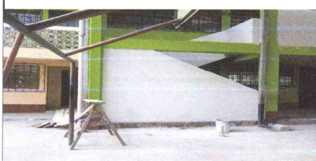
SUMINISTRO Y CONTINJACION DE PARED DE BLOCK EN BARANAS
