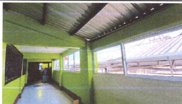
SUMINISTRO Y COLOCACION DE VENTANAS DE PVC
