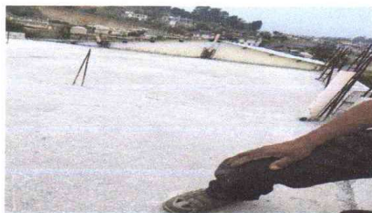
SUMINISTRO Y APLICACIÓN DE PAÑUELOS EN TERRAZA CON TORTA DE CONCRETO
