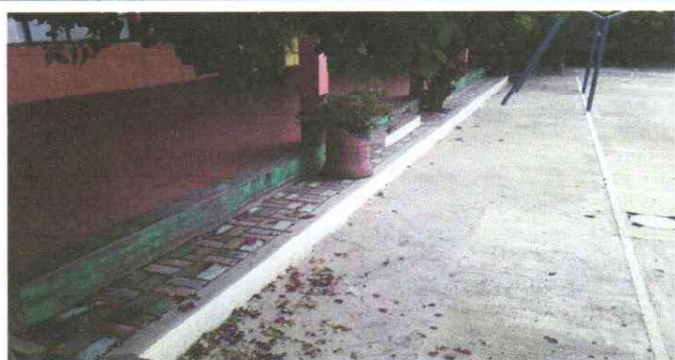
Sustitución de piso con adoquín, tráfico liviano decorativo.
