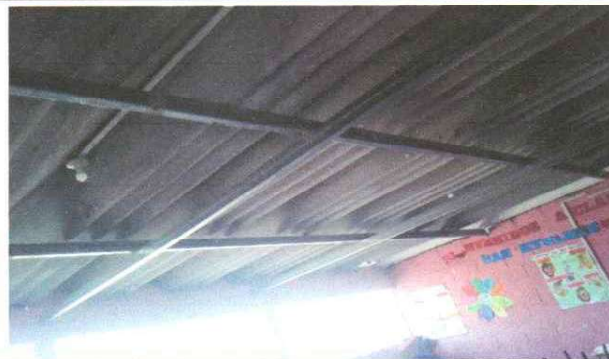
Sustitución de estructura de soporte por metal en 7 aulas.
