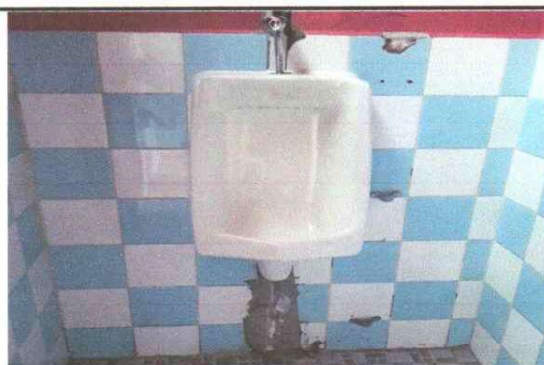
Sustitución de migitorio.
