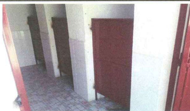
Sustitución de puerta de servicios sanitarios metálica en 6 baños y una principal.
