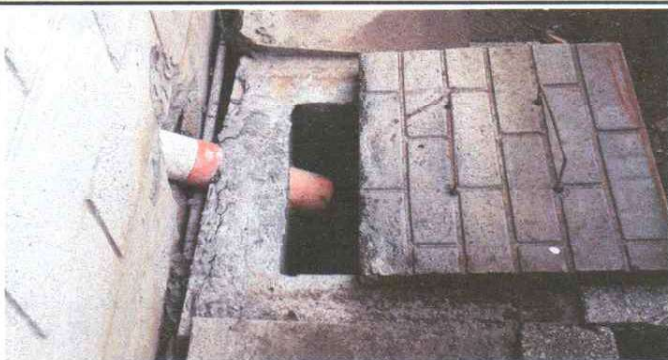
Mantenimiento de caja de registro.
