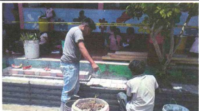
Sustitucion de piso con adoquín, tráfico liviano decorativo.
