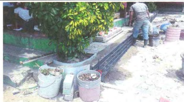
Sustitución de piso con adoquín, tráfico liviano decorativo.
