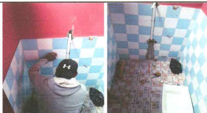
Sustitución de migitorio.
