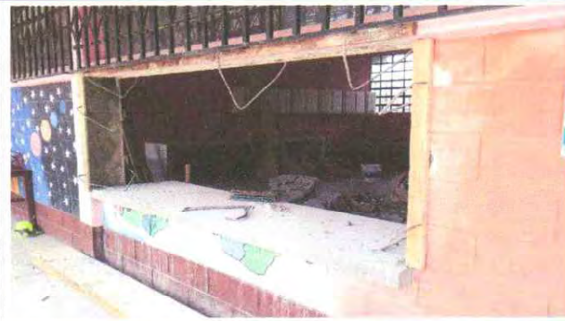
Reparación de mesas de trabajo en cocina, Reparación de cableado eléctrico CALIBRE 12 AWB, Sustitución de tomacorrientes dobles.
