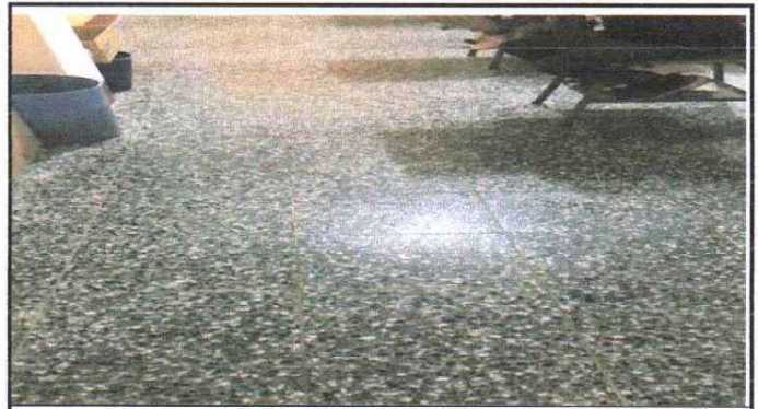
Foto 2: Proyectos finalizados de piso.
