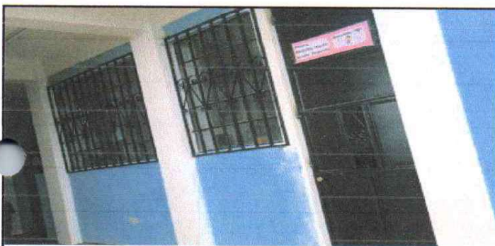
Foto 5: Terminación de proyecto de colocación de puerta.
