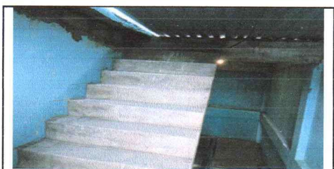
Foto 6: Terminación del proyecto de las gradas.
