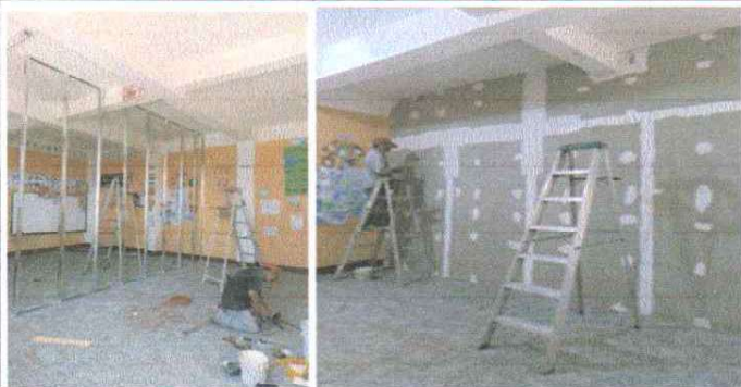
Foto1: Fotografía Suministro y Fabricación de pared prefabricado.
