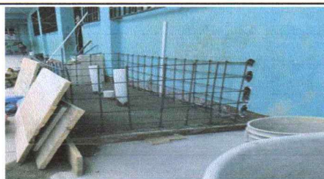
Foto 4: Proceso de la construcción de la pila.
