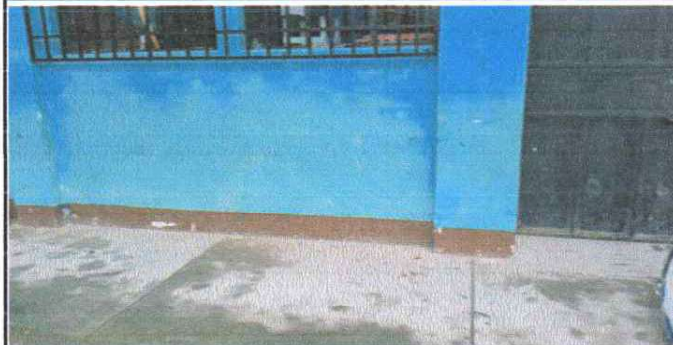
Foto 2: Fotografías suministro de balcones y reja
