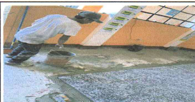
Foto 6: Colocación de Piso de granito .
