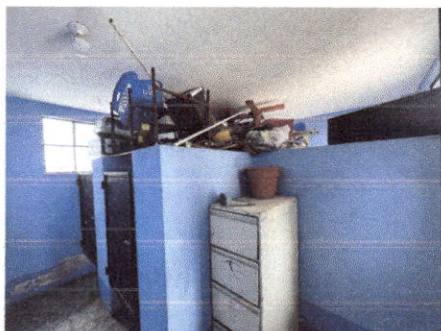
Foto 11: NO CUENTAN CON MIGITORIO, EL MURO QUE DIVIDE LOS SANITARIOS ESTA BAJO
