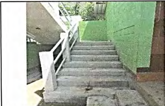
Foto 1: Suministro e instalación de gradas
