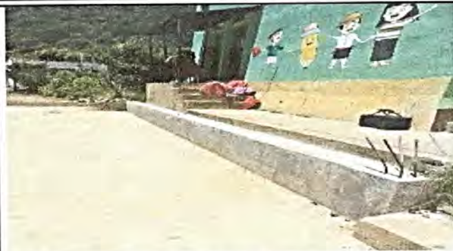
Foto 6: Suministro e instalación de un bordillo
