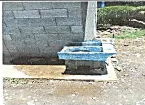
Foto 12: Instalación de cambio de tubería de una pila
