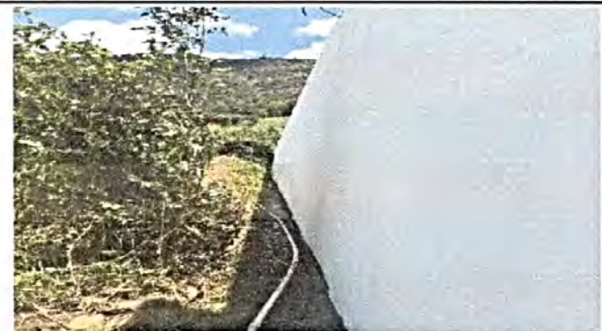
Foto 17: Mantenimiento de una pared de 125 mts cuadrados de pintura impermeabilizante de color blanco
