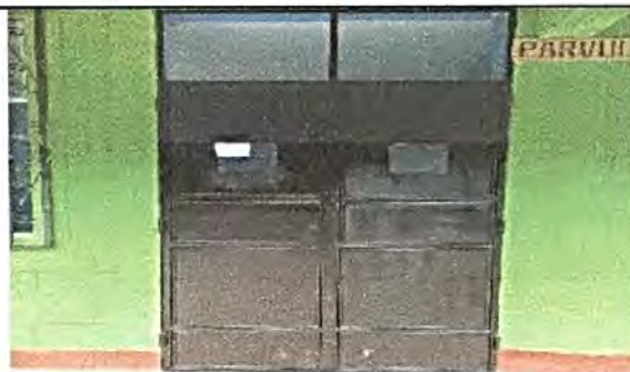
Foto 4: Mantenimiento de puertas (pintura)
