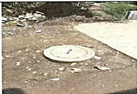
Foto 13: Instalación de tubo general de drenaje
