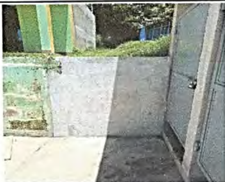
Foto 9: Elaboración de un muro de 1mts por 1 mts de altura
