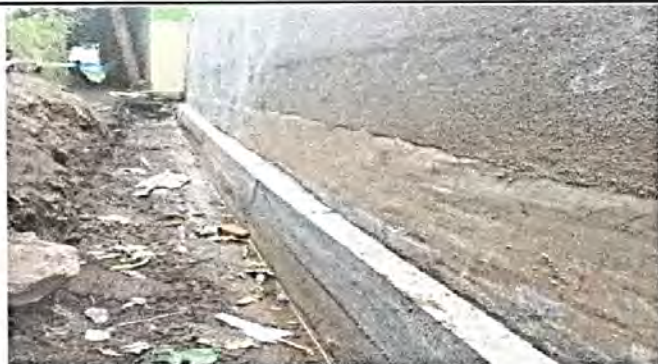
Foto 11: Elaboración de un bordillo de 9.32 mts por 50 cm de altura
