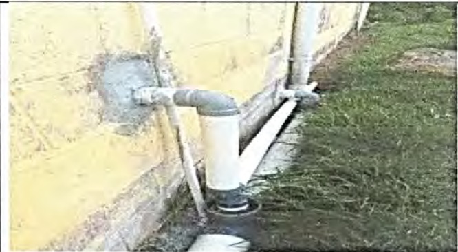
Foto 18: Cambio de accesorios de tubería
