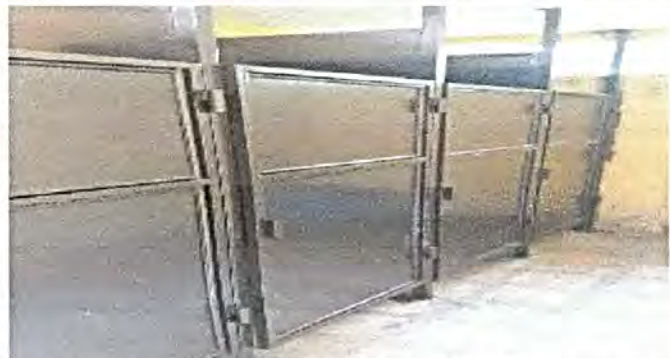
Foto 19: Mantenimiento de las puertas de los baños internos y divisiones
