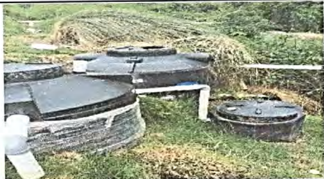
Foto 5: suministro e instalación de un biodigestor de 1,300 lts con caja de registro de lodos
