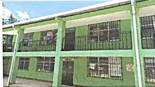
Foto 8: Mantenimiento de 16 balcones y marcos de la ventana
