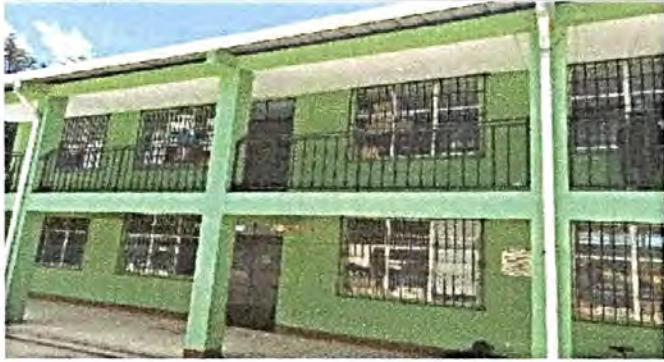
Foto 15: Mantenimiento de baranda de segundo piso
