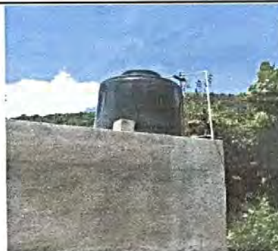
Foto 10: Sustitución de accesorios de un rotoplast
