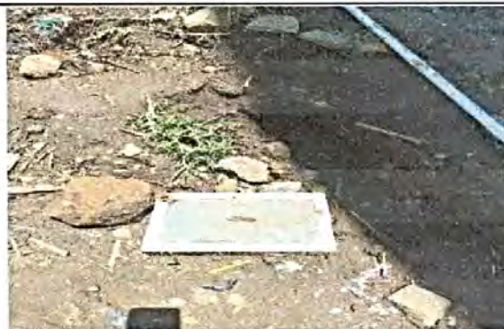
Foto 14: Instalación caja de agua y cambio de llave de paso
