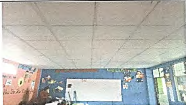
Foto 7: Sustitución del cielo falso de dos aulas
