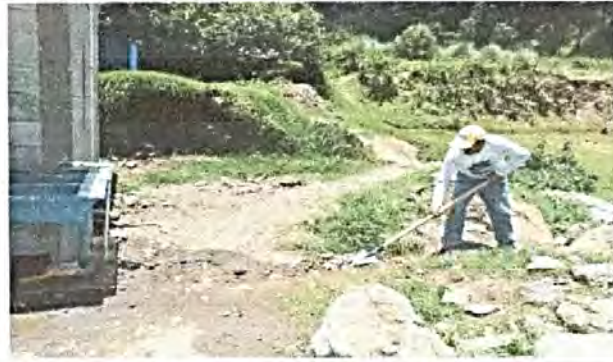
Foto 12: Instalación de cambio de tubería de una pila
