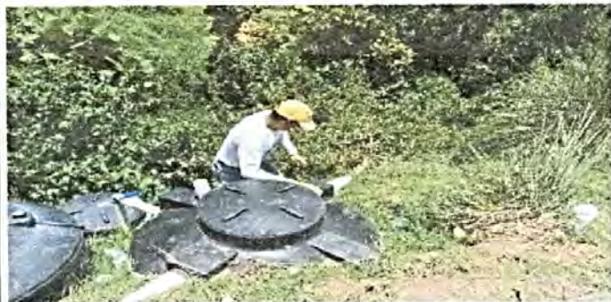
Foto 5: Suministro e instalación de un biodigestor de 1,300 lts con caja de registro de lodos
