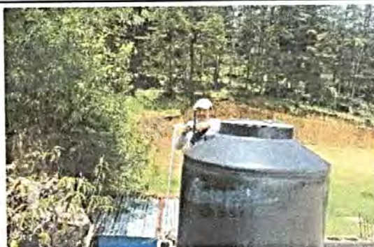
Foto 10: Sustitución de accesorios de un rotoplast
