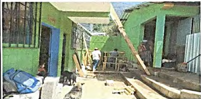
Foto 1: Suministro e instalación de las gradas
