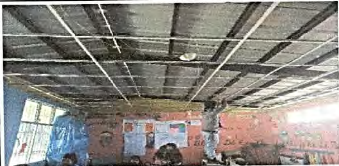
Foto 7: Sustitución del cielo falso de dos aulas
