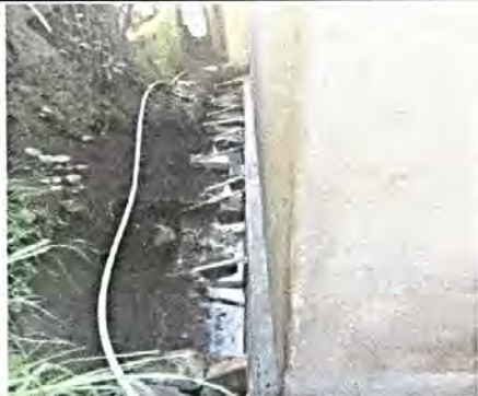
Foto 11: Elaboración de un bordillo de 9.32 mts por 50 cm de altura
