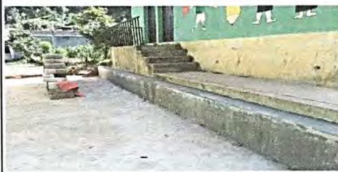
Foto 6: Suministro e instalación de un bordillo
