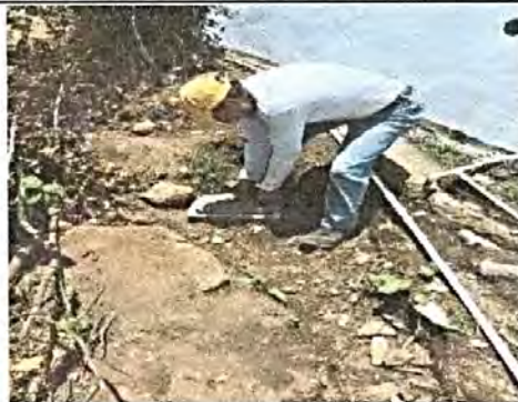
Foto 14: Instalación de caja de agua y cambio de llave de paso
