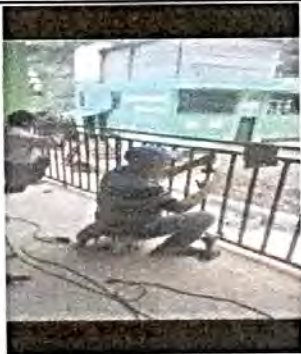
Foto 15 Mantenimiento de baranda de segundo nivel
