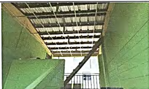
Foto 3: Sustitución del cielo falso con el corredor de las aulas
