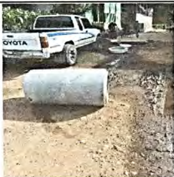
Foto 13: Instalación de tubo general de drenaje
