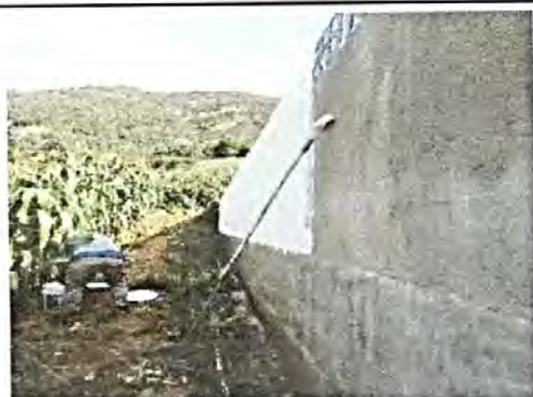
Foto 17: Mantenimiento de una pared de 125 mts cuadrados de pintura impermeabilizante de color blanco
