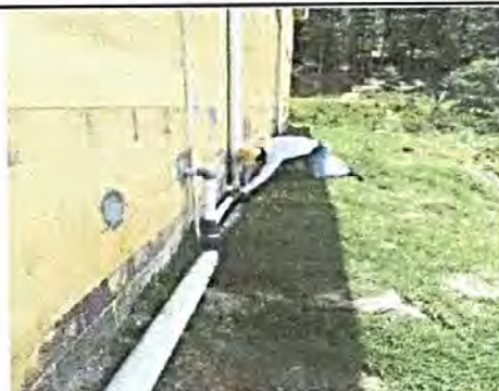
Foto 18: Camio de accesorios de tubería
