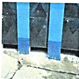
Foto 5: Reparación de 2 puertas de metal.
