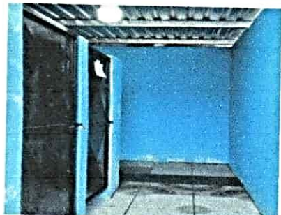
Foto1: Suministro e instalación de 2 cabinas sanitarias para adulto, suministro e instalación de un mingitorio, suministro e instalación de lámina troquelada calibre 26, suministro e instalación de paredes de block.
