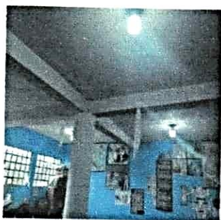
Foto 3: Suministro e instalación de energía eléctrica en 5 aulas, bodega de refacción, dirección, cocina y patio.
