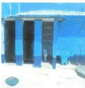
Foto 5: Reparación de 2 puertas de metal.
