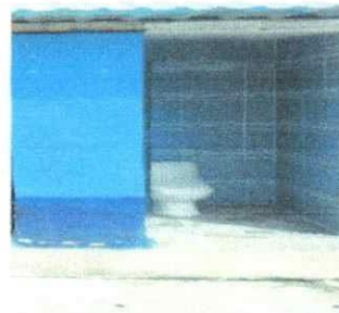
Foto 2: Suministro e instalación de 2 tazas sanitarias para niño.
