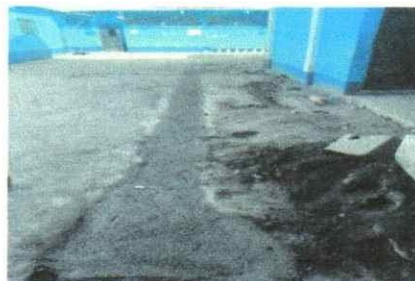
Foto 4: Suministro e instalación de drenaje de aguas negras y suministro e instalación de caja de registro de drenaje.
