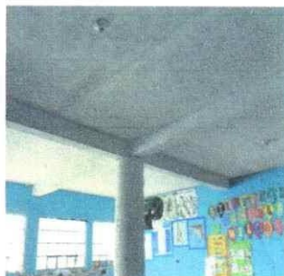
Foto 3: Suministro e instalación de energía eléctrica en 5 aulas, bodega de refacción, dirección, cocina y patio.
