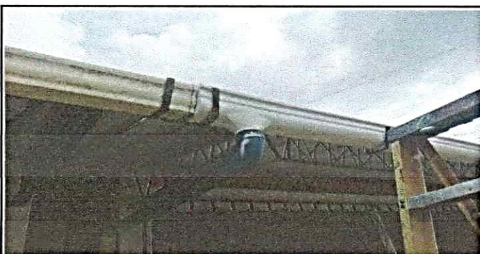
Foto 3: Sustrucción de canal de pvc Finalizado
