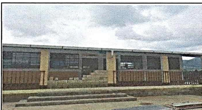
Foto 4: Sustrucción de canal de pvc Finalizado
