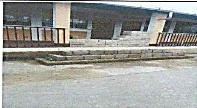
Foto 2: Sustitución de piso de torta de concreto
