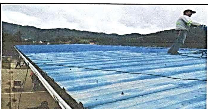
Foto 6: Mantenimiento a estructura de lámina con aticorrosivo
