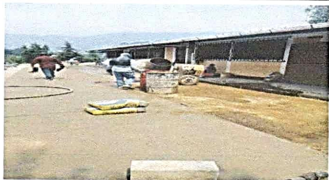
Foto 1: Sustitución de piso de torta de concreto
