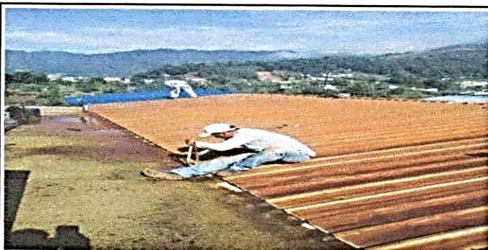
Foto 5: Mantenimiento a estructura de lámina con aticorrosivo
