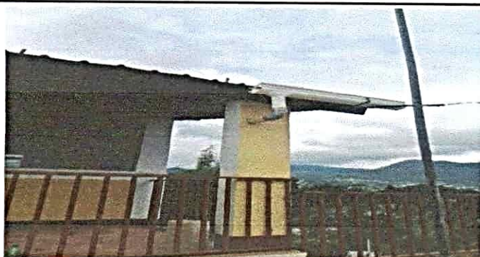
Foto 3: Sustitución de canal de pvc
