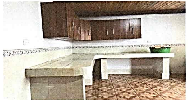
Foto 6: FINALIZACION DE MESA DE CONCRETO, PISO DE CERAMICA Y GABINETE FIJO
