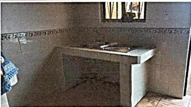
Foto 5: FINALIZACION DE LAVAMANOS
