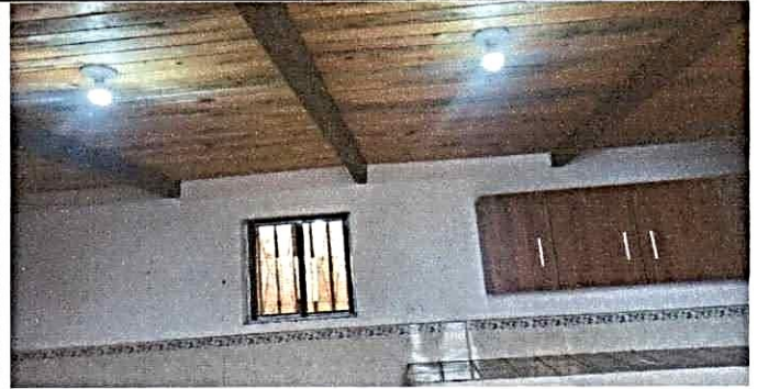
Foto 4: FINALIZACION DE MACHIMBRE
