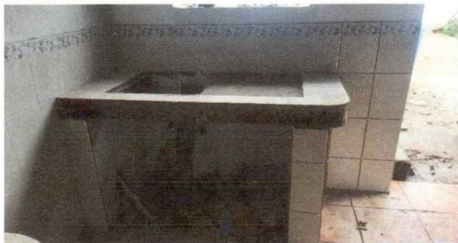
Foto 5: CONSTRUCCION DE LAVAMANOS
