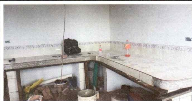
Foto 6: CONSTRUCCION DE MESA DE CONCRETO, PISO DE CERAMICA Y GABINETE FIJO
