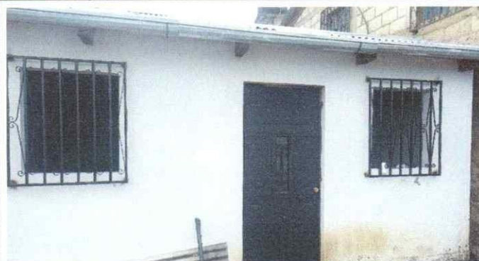
INSTALACION DE VIDRIERAS, PUERTA Y BALCONES
