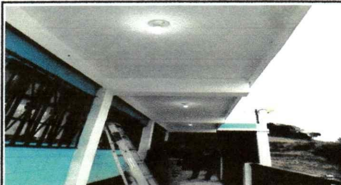
Foto 4: cambio de focos en el corredor
