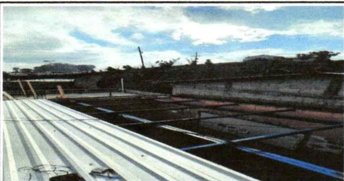
Foto 3: entechado de aulas
