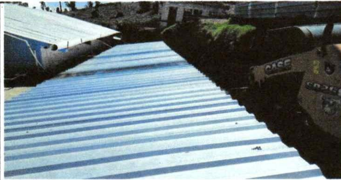
Foto 1: entechado de baños
