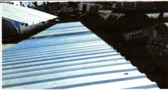
Foto 1: entechado de baños
