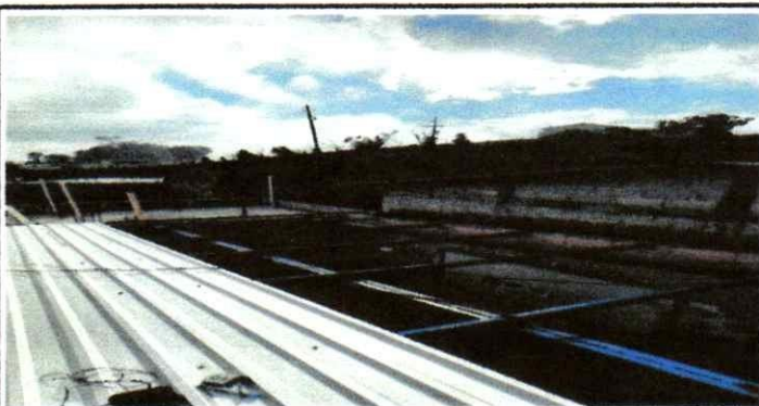
Foto 3: entechado de aulas
