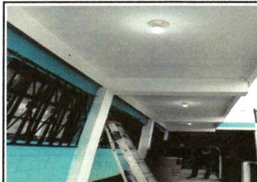
Foto 4: cambio de focos en el corredor
