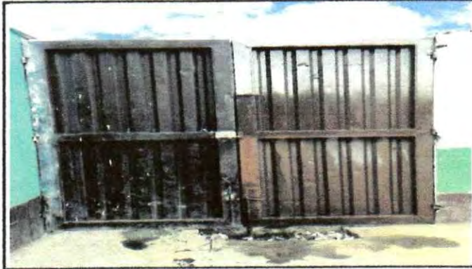
Foto 2: Inicio de trabajo de reparación de portones
