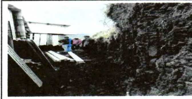
Foto 6: Materiales para iniciar el trabajo de muros
