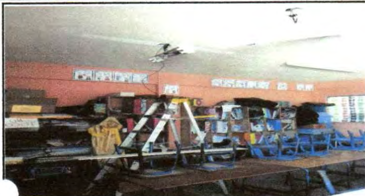
Foto 1: Inicio de trabajo de Instalación Eléctrica
