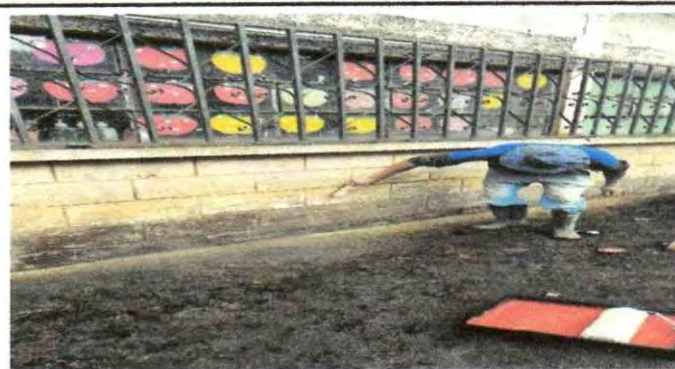
Foto 4: Inicio de trabajo de aplicación de impermeabilizante
