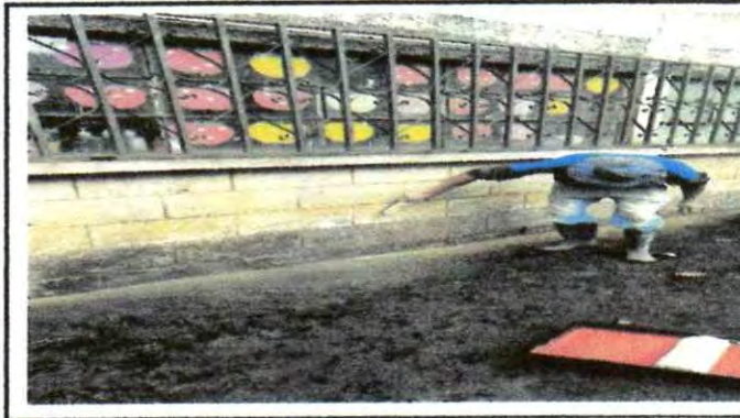
Foto 4: Inicio de trabajo de aplicación de impermeabilizante
