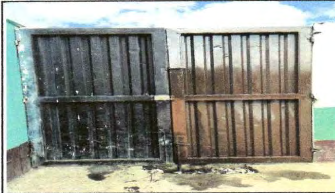
Foto 2: Inicio de trabajo de reparación de portones
