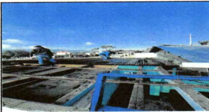
Foto 3: Inicio de trabajo de cambio de techo de 1 aula y dirección
