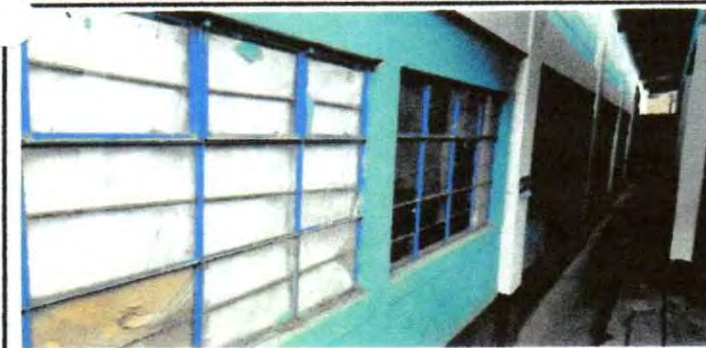
Foto 5: inicio de trabajo de la colocación de balcones
