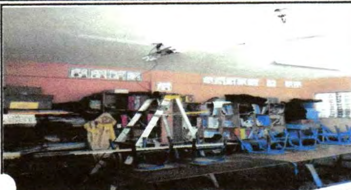
Foto 1: Inicio de trabajo de Instalación Eléctrica
