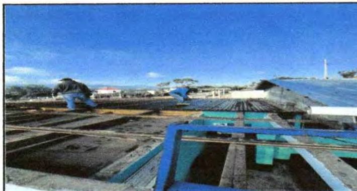
Foto 3: Inicio de trabajo de cambio de techo de 1 aula y dirección
