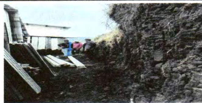
Foto 6: Materiales para iniciar el trabajo de muros
