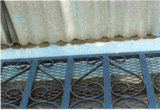
Foto1: Suministro e instalación de costaneras galvanizadas de 2x4 y tubo rectangular de 1x2 para darle resistencia a las láminas y sellar para evitar ingreso de aves.
