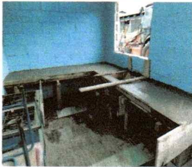
Foto1: SUMINSITRO E INSTALACIÓN DE LAVASTRASTOS DE CON PLANCHA DE CONCRETO CON GABINETE INFERIOR CON AZULEJO Y DRENAJE
