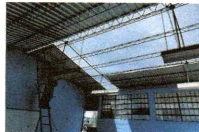
Foto: 6 Suministro y mantenimiento a estructura de techo, se desmontara la totalidad de la lámina, para instalar plaquetas de estructura tipo yoyo, para sujetar y reforzar con tornillos poolser.
