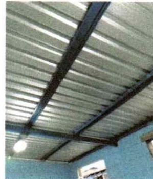
Foto 4: Sustitución de estructura de madera y cubierta de lámina por suministro e instalación de costaneras, chapa 16 y tubos rectangulares de 2x4 y reinstalación de lámina.
