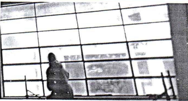
Foto 5: Colocacion de vidrios del modulo no.2
