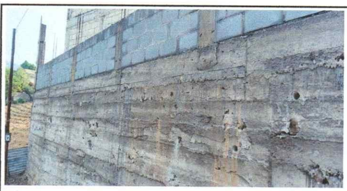
Foto 4: VISTA FINALIZACIÓN DEL PROYECTO
