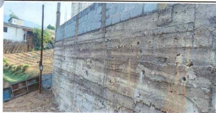
Foto 5: PROYECTO EN EJECUCION EL 100%
