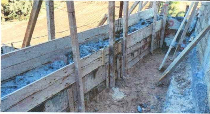
Foto1: VISTA ejecución del proyecto
