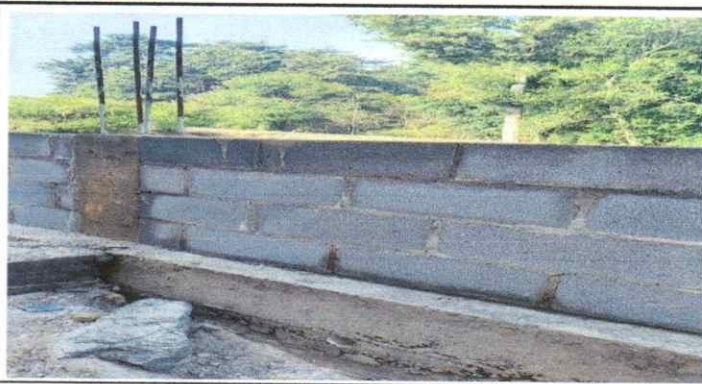
Foto 3: VISTA INSPECCION DEL PROYECTO
