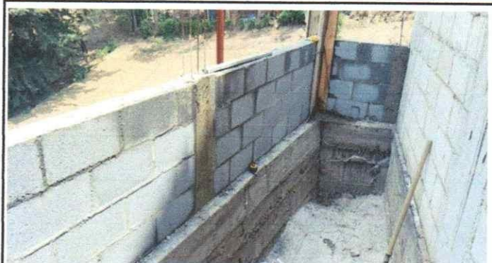
Foto 2: ejecución del proyecto 80% ciento
