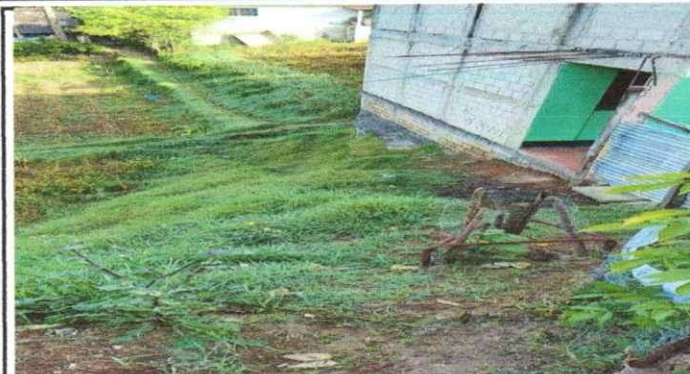
Foto 2: Sustitución de muro de contención
