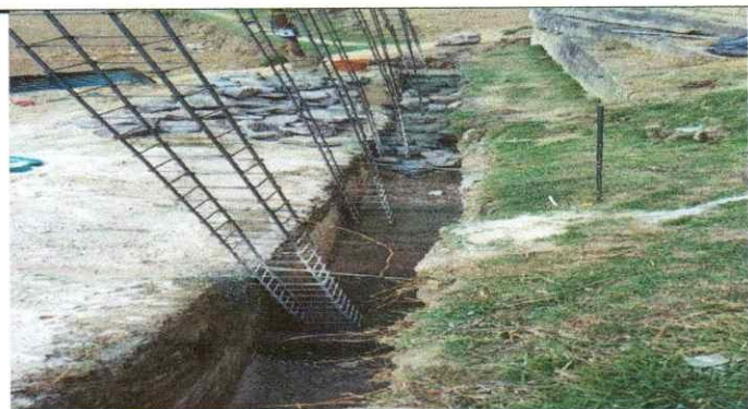
Foto 3: Dotación de material
