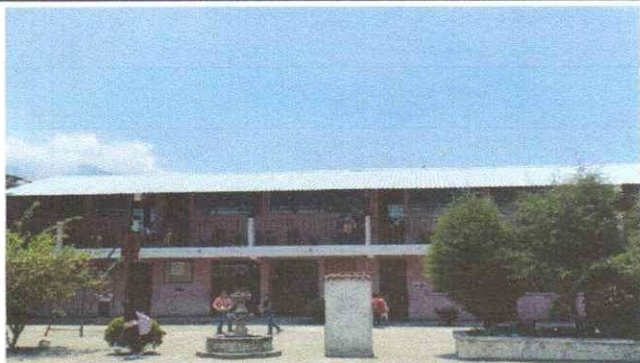
Foto1: VISTA FACHADA INTERIOR LAMINA COLOCADA AL 100%
