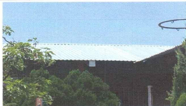
Foto 2: VISTA DE INSTALACIÓN DE LÁMINA FINALIZADO
