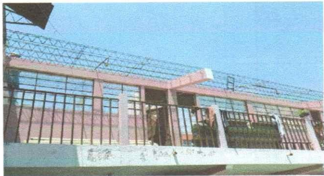
Foto1: RETIRO DE LÁMINAS ANTIGUAS
