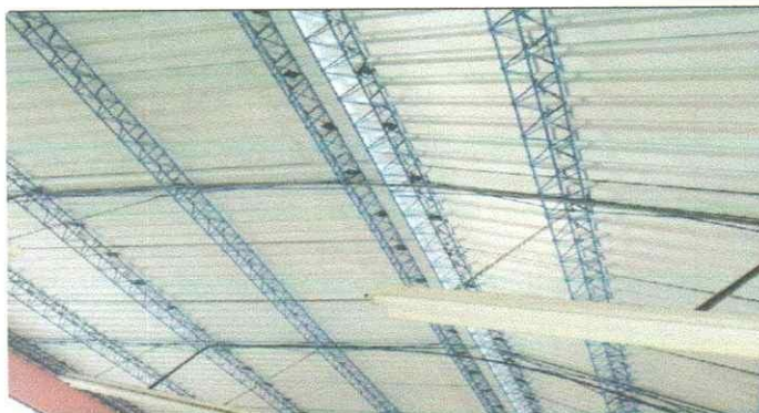
Foto 4: MANTENIMIENTO DE PINTURA EN ESTRUCTURA METALICA EXISTENTE
