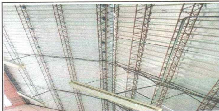
Foto 5: SUMINISTRO E INSTALACIÓN DE LÁMINAS
