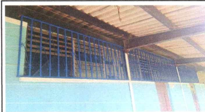
Foto 3: Suministro e instalacion de balcones
