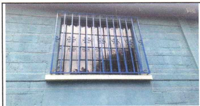
Foto 5: Mantenimiento de ventanas de metal
