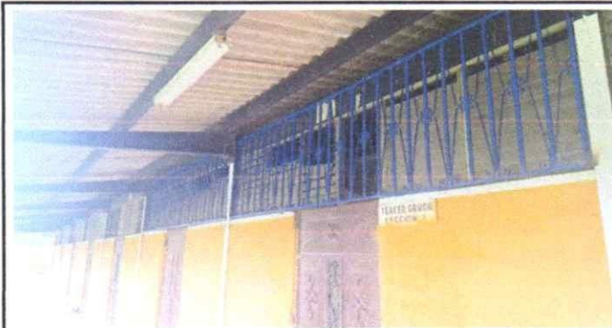
Foto1: Suministro e instalacion de balcones
