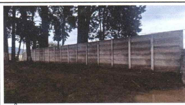
Foto 6: Suministro e instalacion de muro prefabricado de concreto reforzado
