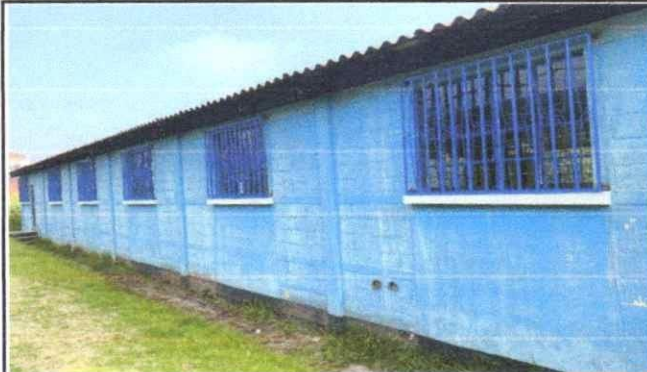
Foto 4: Suministro e instalación de balcones
