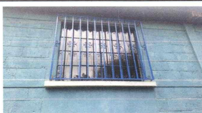
Foto 2: suministro e instalacion de vidrio transparente
