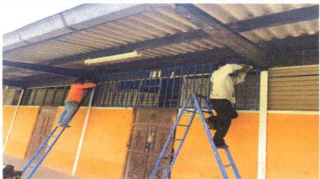
Foto1: Suministro e instalacion de balcones
