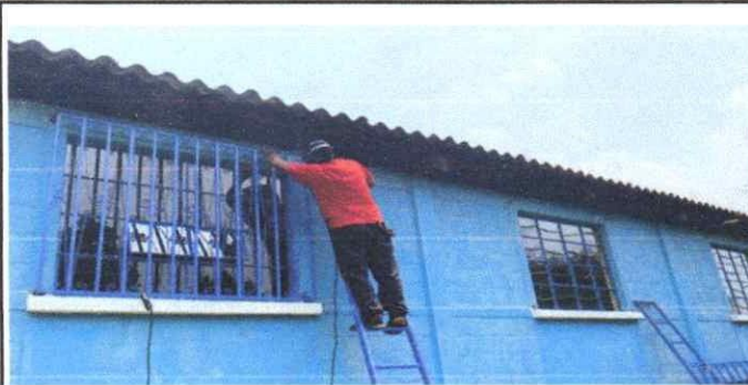
Foto 4: Suministro e instalación de balcones
