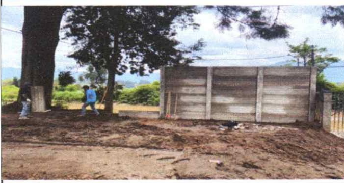
Foto 6: Suministro e instalacion de muro prefabricado de concreto reforzado
