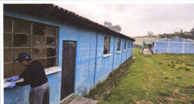
Foto 5: Mantenimiento de ventanas de metal
