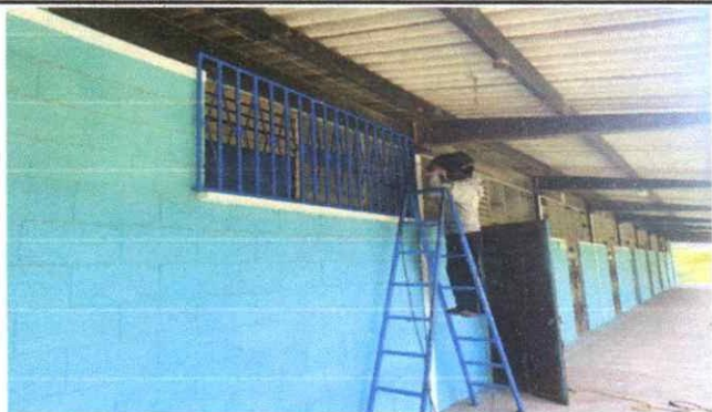
Foto 3: Suministro e instalacion de balcones
