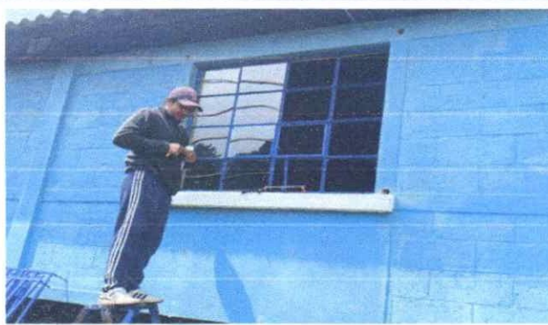
Foto 2: suministro e instalacion de vidrio transparente
