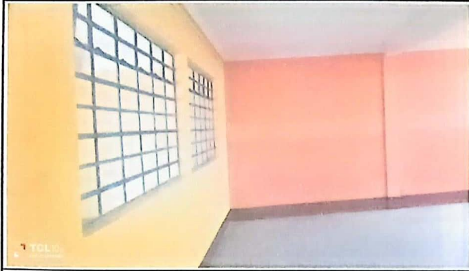
Foto1: La construccion o sustitución de la pared
