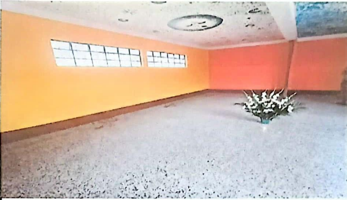
Foto 3: La construccion o sustitución de la pared
