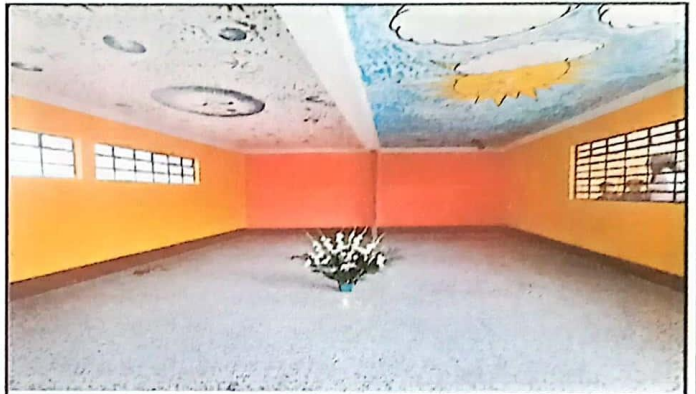
Foto 4: La construccion o sustitución de la pared
