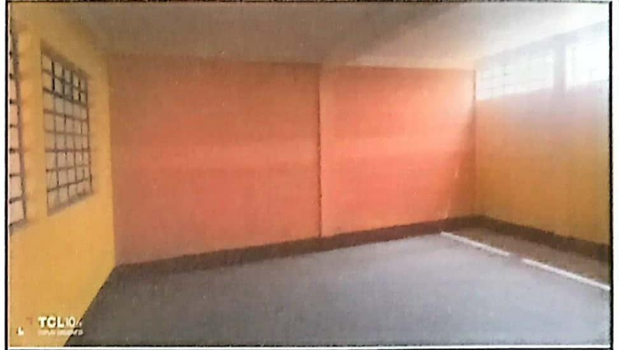
Foto 2: La construccion o sustitución de la pared
