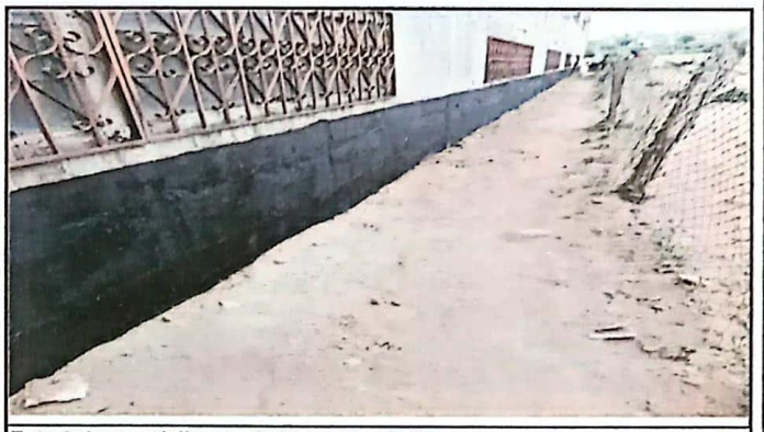
Foto 6: Impermializante de la pared exterior
