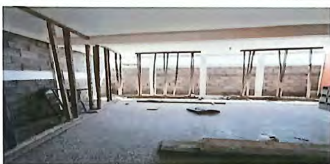
Foto 5: TERMINANDO LA COLOCACION DE BLOCK EN UNA CLASE DE UN AULA
