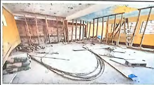
Foto 2: DEMOLIENDO LAS PAREDES DE LA PRIMERA CLASE
