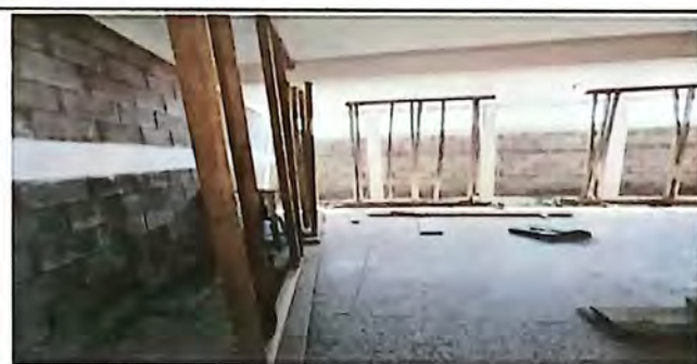
Foto 6: TERMINACION DE LEVANTAMIENTO DE LA PARED DE UN AULA
