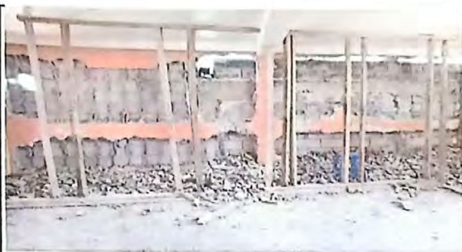
Foto 3: EN DEMOLICION DE LAS PAREDES DE LA SEGUNDA AULA
