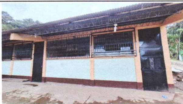
Foto 3: Aplicación de pintura interior y exterior
