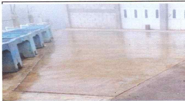
Foto 2: Resultado final de la torta de cemento en el patio de la escuela
