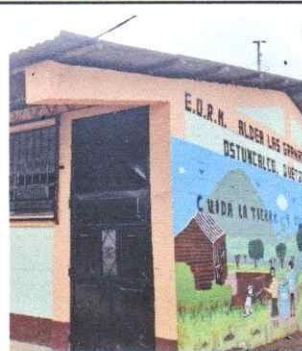
Foto 4: cambio y reparacion de puertas de metal.
