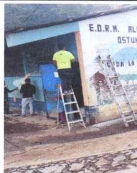
Foto 4: cambio y reparacion de puertas de metal.
