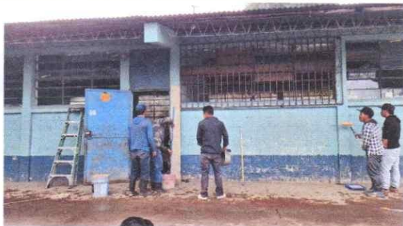
Foto 3: Aplicación de pintura exterior e interior
