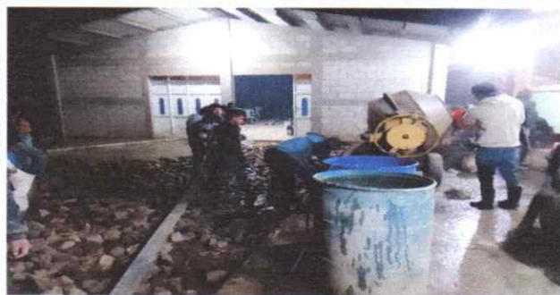
Foto 2: Fundición torta de cemento en el patio de la escuela
