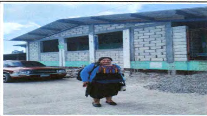
11.1 sustitucion instalacion de Balcones
