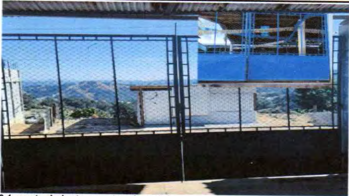
12.1 mantenimiento a porton de metal.
