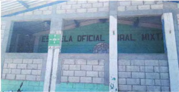
5,2 instalacion de ventanas en aula
