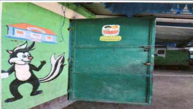
4.1 MANTENIMIENTO A ESTRUCTURA DE PUERTA
