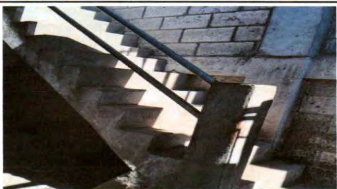
4. instalcion de una puerta nueva para gradas.
