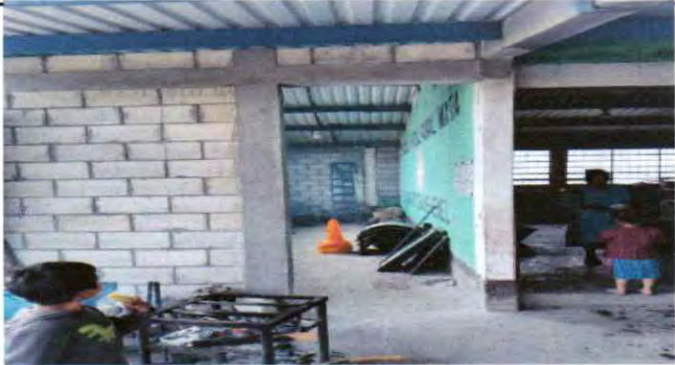
Instalación de una puerta nueva metalica Enchapada
