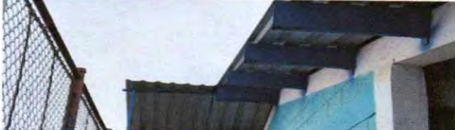
2.2 SUSTITUCION DE DE ESTRUCTURA DE SOPORTE CON INSTALACION DE LAMINA.
