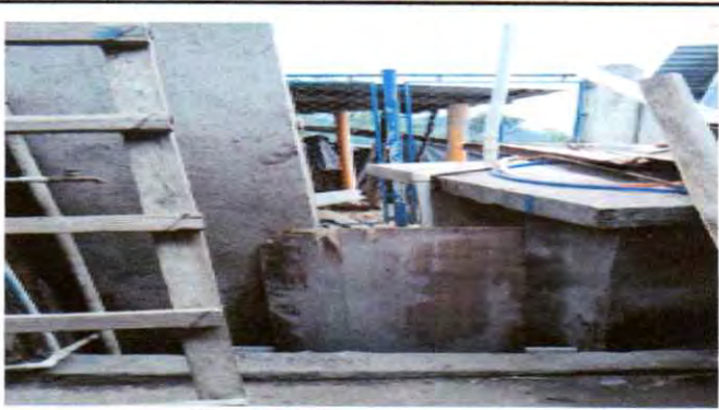
4. instalacion de puerta para seguridad de tanque de agua y sistema de bombeo.
