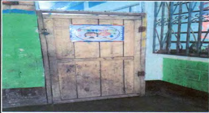
4. sustitucion de puerta
