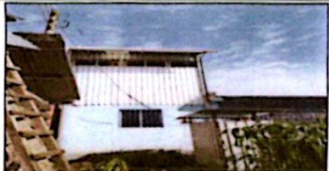
Foto 2: VISTA DE LA PARTE ATRAS DE LA OBRA SEGUNDO NIVEL
