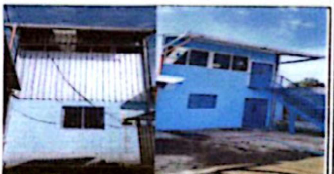
Foto 4: VISTA AMBOS LADOS DE OBRA DE SEGUNDO NIVEL
