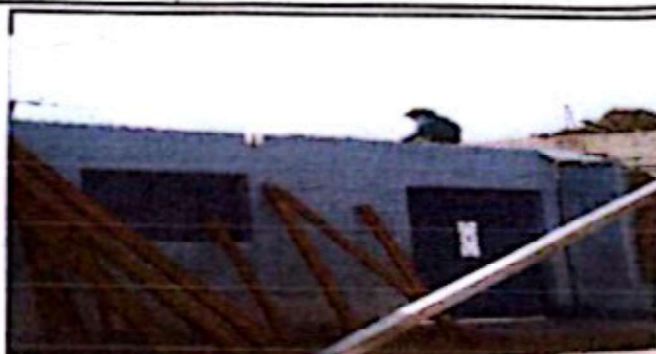
Foto 2: RETIROS DE VIGAS DEL AULA PRIMER NIVEL
