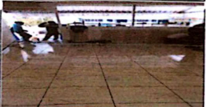
Foto 5: COLOCACIÓN DEL PISO CERÁMICA DEL SEGUNDO NIVEL
