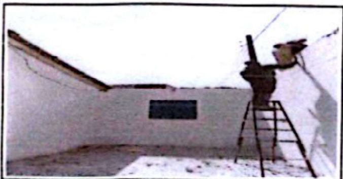
Foto 3: DEMOLICION DE LAS COLUMNAS PRIMER NIVEL
