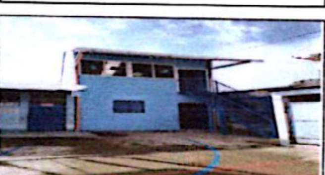
Foto 6: OBRA FINALIZADA PARTE FRONTAL
