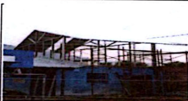
Foto 4: IMPLEMENTACION DE LAS ESTRUCTURAS METÁLICAS SEGUNDO NIVEL
