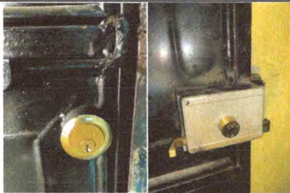
Foto 3: VISTA EXTERIOR E INTERIOR DE CAMBIO DE CHAPAS CERRADURA.
