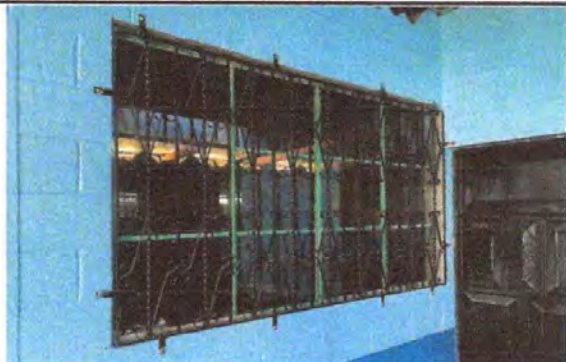
Foto 15: VISTA DE BALCON REPARADO (sujeciones, lijado y aplicación de pintura) 100% FINALIZADA.
