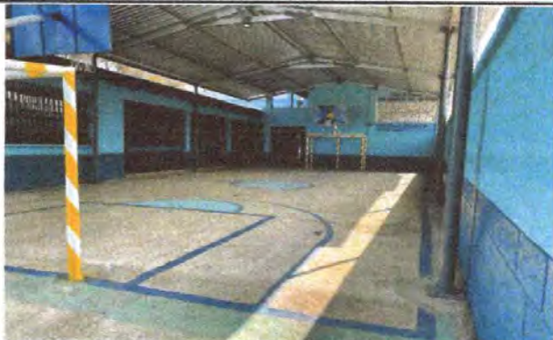
Foto 14: VISTA DE APLICACIÓN DE PINTURA EXTERIOR FINALIZADO
