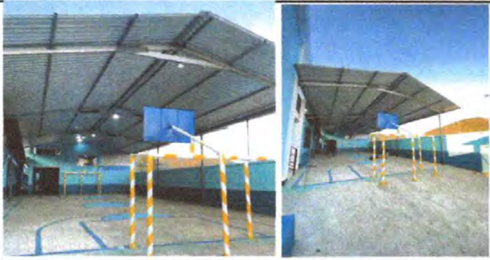
Foto 12: VISTA EXTERIOR DE INSTALACIÓN DE LAMINA TROQUELADA CALIBRE 24 Y ESTRUCTURA PORTANTE DE TECHO.
