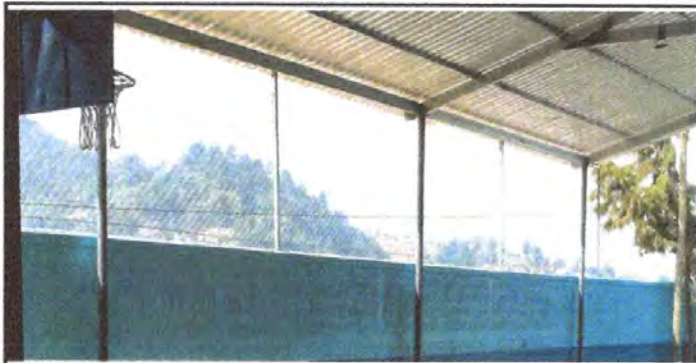
Foto 15: VISTA DE MALLA GALVANIZADA 100% FINALIZADA.
