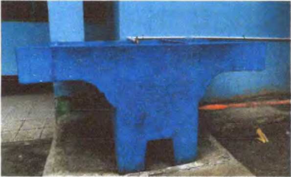
Foto 11: VISTA DE SUSTITUCIÓN DE PILA FINALIZADO.
