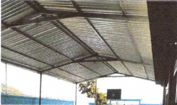
Foto13: VISTA INTERIOR DE INSTALACIÓN DE LAMINA TROQUELADA CALIBRE 24 Y ESTRUCTURA PORTANTE DE TECHO
