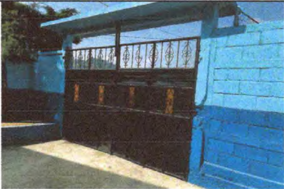
Foto1: VISTA INTERIOR DE MANTENIMIENTO DE PORTON 100% FINALIZADO
