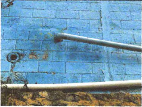
Foto 8: VISTA DE INSTALACIÓN DE TUBERIAS PVC 3" AGUAS NEGRAS, 100% FINALIZADO
