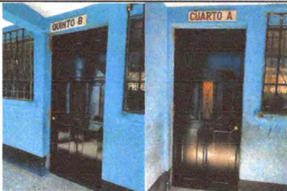
Foto 2: VISTA DE INSTALACIÓN DE PUERTAS FINALIZADO
