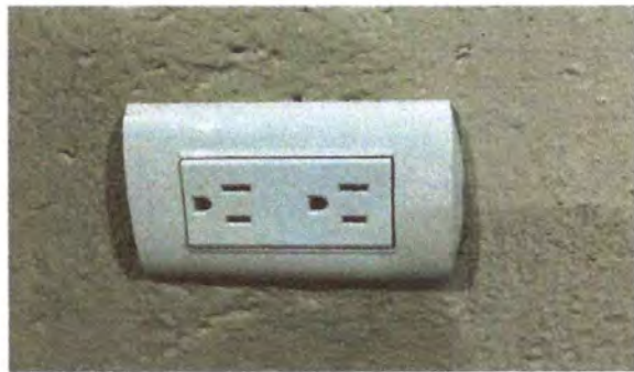
Foto 6: INTERIOR DE LAS AULAS CON SUSTITUCIÓN DE TOMACORRIENTES DOBLE
