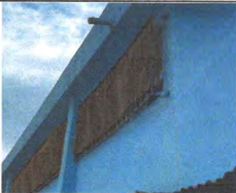
Mantenimiento de balcones (sujeciones)
