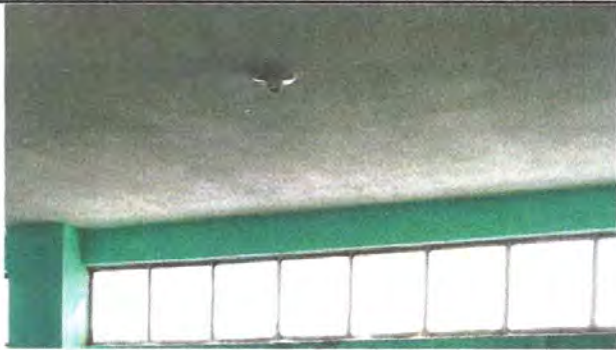
Sustitución de bombillos Led, toma de corrientes dobles y cableado.
