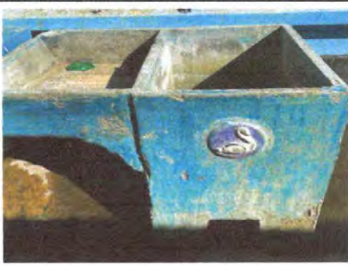
Sustitución de pila de concreto.
