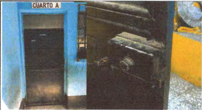
Sustitución de puerta metálica de aulas y sustitución de chapas cerradura sobreponer y engrape.
