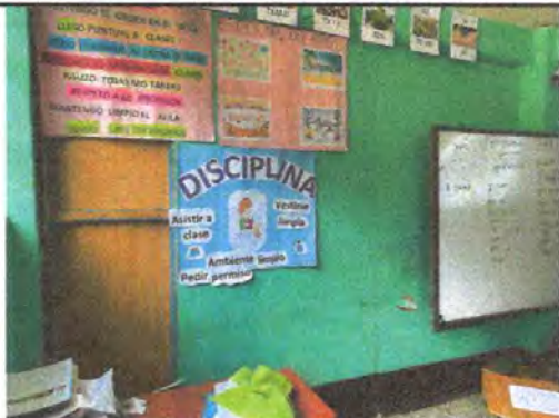
Sustitución de pared de material de tabla yeso por plywood 3/4 y accesorios, en aulas.
