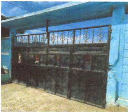
Mantenimiento a porton de metal.
