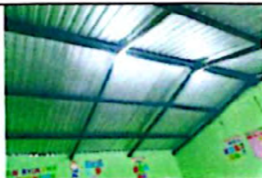
Limpieza y pintura en estructura de metal
