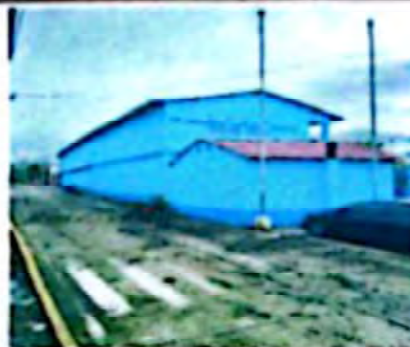
Pintura de pared parte exterior de la escuela
