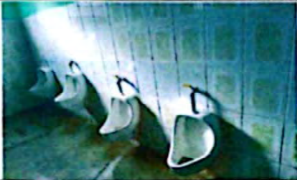
Sustitución de mingitorio
