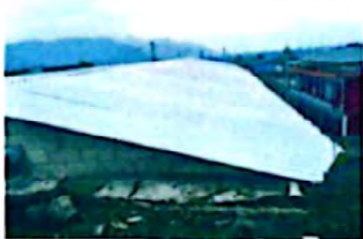
Instalación de lámina troquelada
