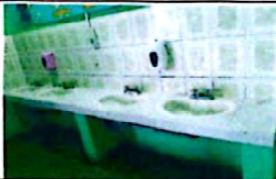
Reparación de lavamanos
