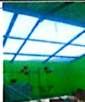
Limpieza y pintura en estructura de metal
