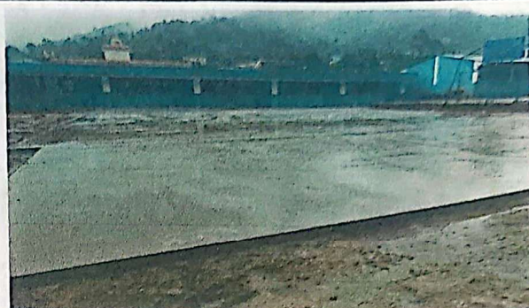
Foto 2: VISTA DE FUNDICIÓN DE CONCRETO AL 100%
