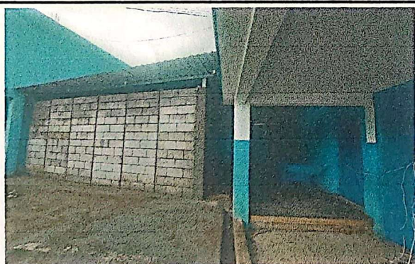
Foto 5: VISTA EXTERIOR DEL AULA CON SUMINISTRO E INSTALACIÓN DE LAMINAS Y BLOCKON FINALIZADO
