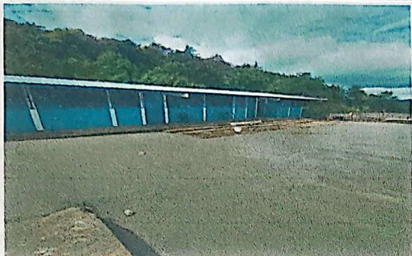
Foto 1: VISTA DE FUNDICIÓN DE CONCRETO AL 100%
