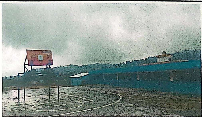
Foto 3: VISTA DE FUNDICIÓN DE CONCRETO AL 100%
