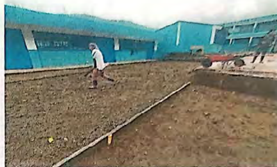
Foto 2: Suministros y fundición
