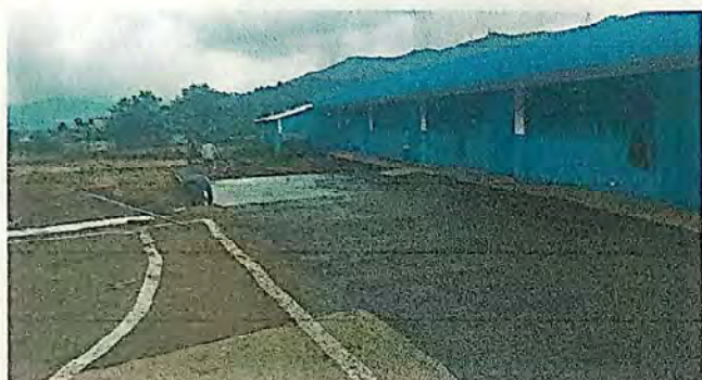
Foto 3: Suministro y fundición
