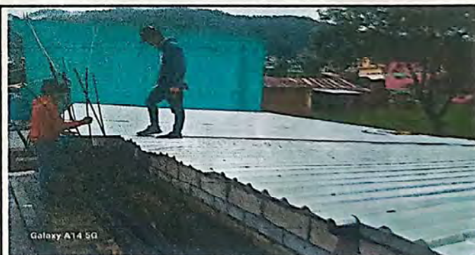
Foto 6: FINALIZA LA COLOCACIÓN DE LÁMINAS
