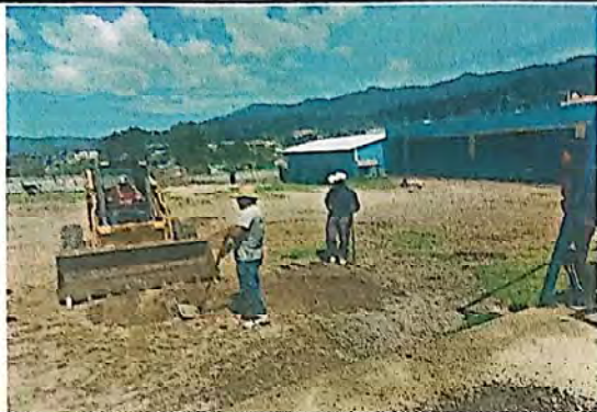
Foto1: Nivelación de área de fundición
