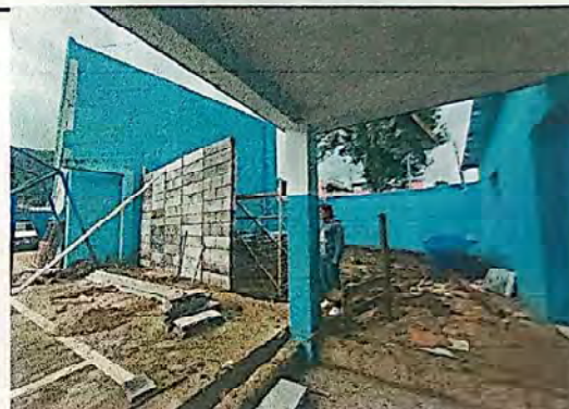
Foto 4: SUMINISTRO E INSTALACIÓN DE BLOKON
