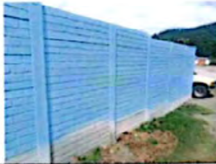
Suministro y aplicación de Pintura de muro perimetral, ambos lados 140 m2
