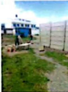
Mano de obra para instalación de muro perimetral prefabricado 65m2
