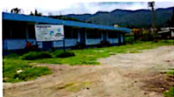
Suministro e instalación de Planchas de dos caras muro prefabricado
