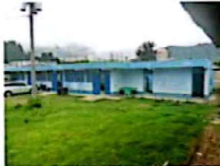
Suministro e instalación de Columnas Tipo H Mediana
