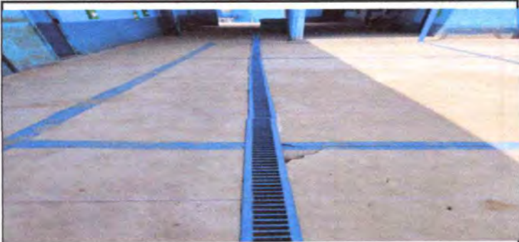
Suministro e instalación de rejilla de metal
