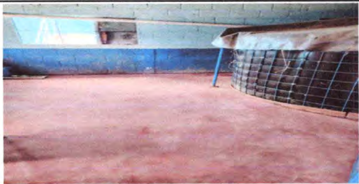
Sustitución de torta de piso alisado
