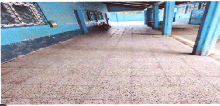
Sustitución de piso a granito de marmol
