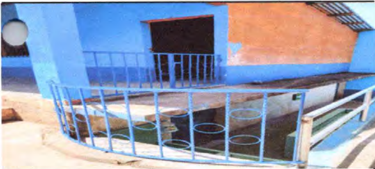
Suministro e instalacion de baranda de metal
