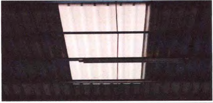
Sustitución de láminas a láminas transparentes
