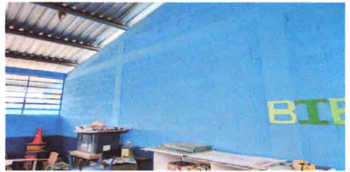
Mantnimiento y aplicación de pintura de 3 aulas
