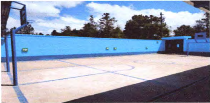
Sustitución de porterías y tableros
