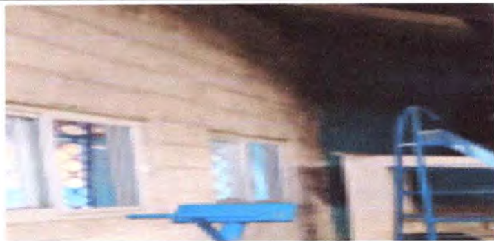
Sustitución de vidrios
