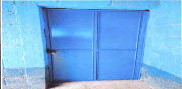
Mantenimiento y pintura de puertas
