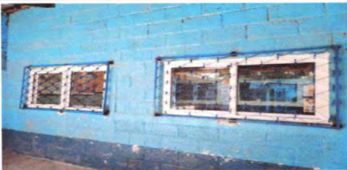
Sustitución de ventanas a PVC
