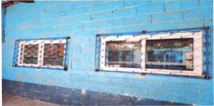
Mantenimiento de balcones
