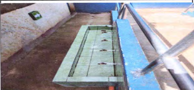
Sustitución de multichorros
