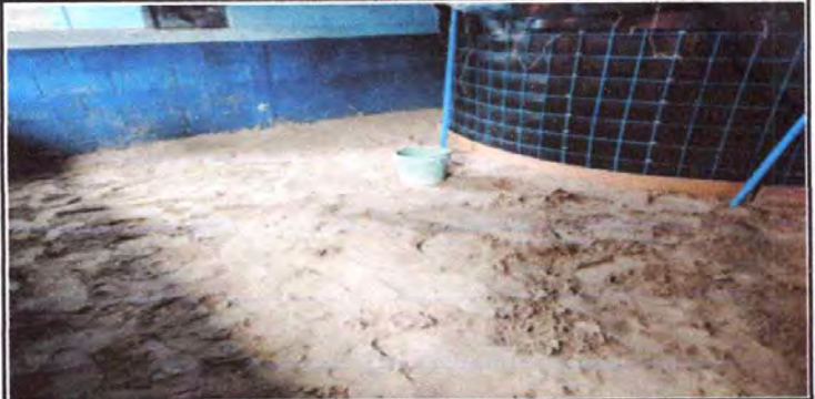
Sustitución de torta de piso alisado
