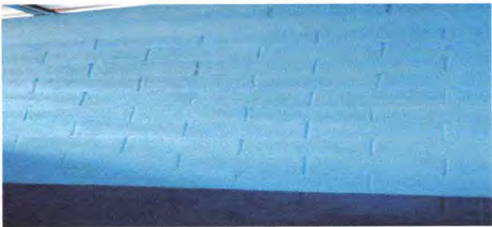
Mantenimiento y aplicación de pintura en 3 aulas
