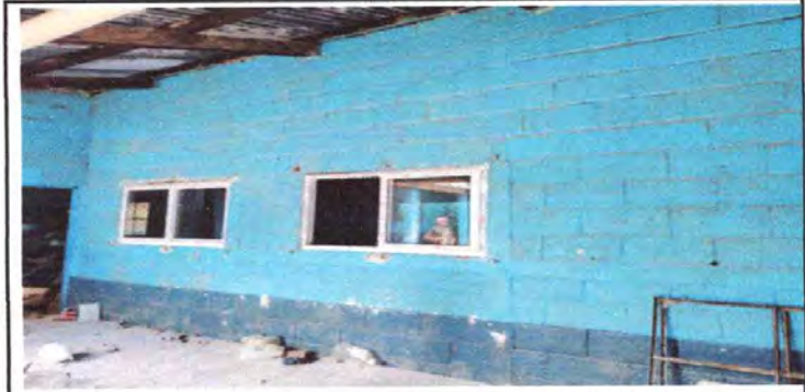
Sustitución de ventanas a PVC
