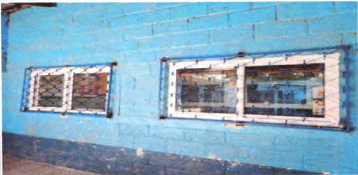
Mantenimiento de balcones
