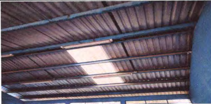
Sustitución de láminas a láminas transparentes
