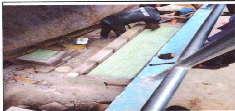
Sustitución de multichorros
