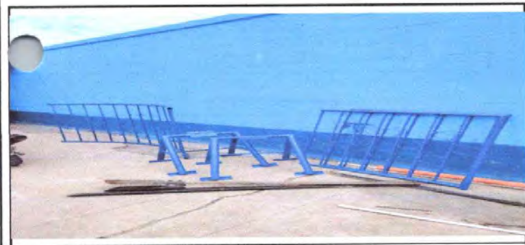
Suministro e instalacion de baranda de metal
