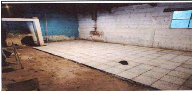
Sustitución de piso a granito de marmol
