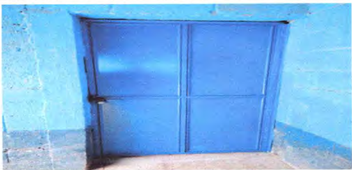
Mantenimiento y pintura de puertas
