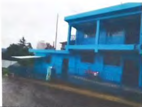
Foto 1: INSTALACIÓN DE BARANDAS.
