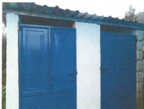
Foto 2: MANTENIMIENTO DE MUROS DE BAÑOS (REPELLO)
