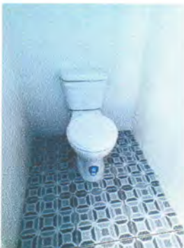
Foto1: INSTALACIÓN DE TASAS PARA BAÑOS.
