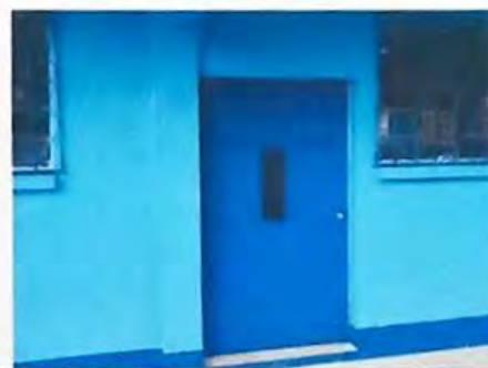
Foto 6: SUSTITUCIÓN DE PUERTAS.
