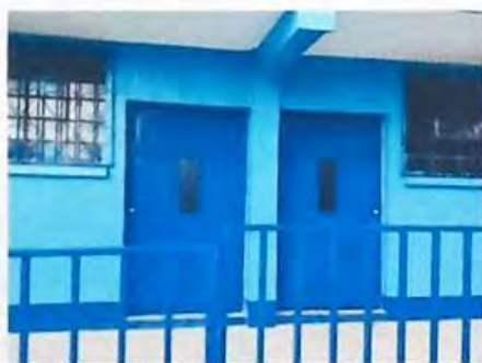
Foto 5: APLICACIÓN DE PINTURA EN PUERTAS Y BARANDAS.
