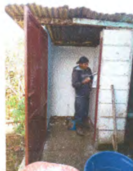
Foto 2: MANTENIMIENTO DE MUROS DE BAÑOS (REPELLO)
