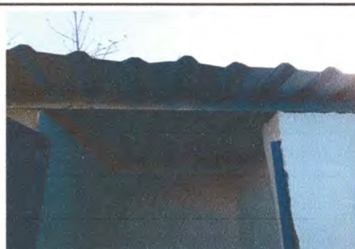
Foto 4: SUSTITUCIÓN DE LÁMINA DE TECHO PARA BAÑOS.
