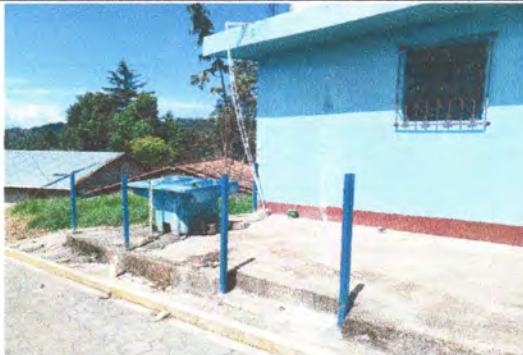
Foto1: INSTALACIÓN DE BARANDAS
