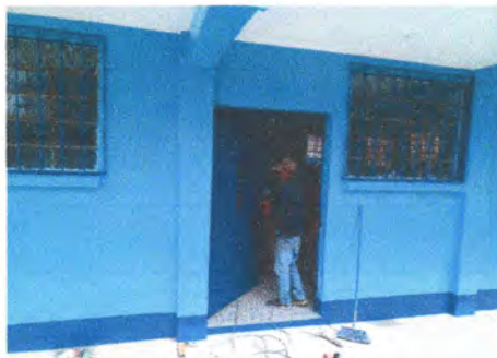
Foto 5: APLICACIÓN DE PINTURA EN PUERTAS Y BARANDAS.
