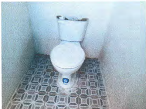
Foto1: INSTALACIÓN DE TASAS PARA BAÑOS.
