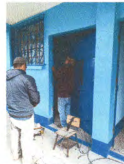
Foto 6: SUSTITUCIÓN DE PUERTA.
