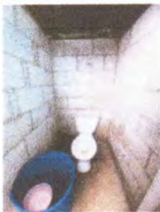
Instalación de 2 tasas lavables para baños.
