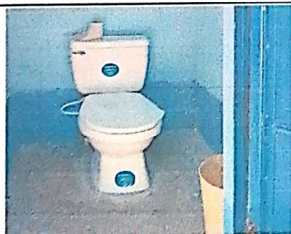
Foto 5: mantenimiento de baños, 2 tasas
