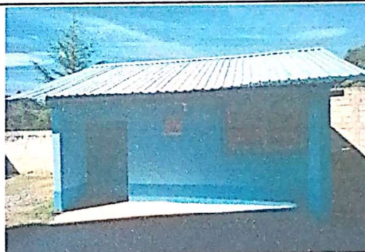
Foto 4: Mantenimiento de cocina, pintura
