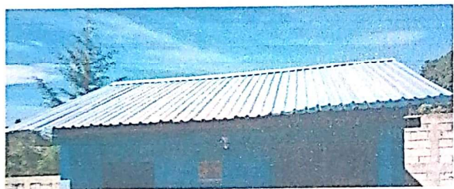
Foto 3: Techo de lamina troquelada con estructura de metal
