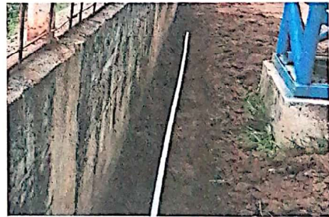
Foto 6: Instalación de agua entubada
