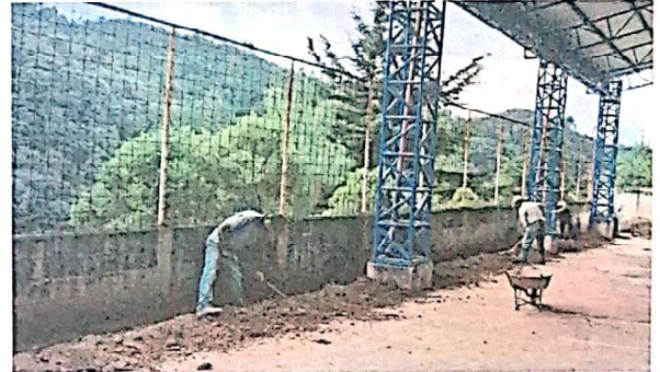
Foto 4: Instalación de agua entubada
