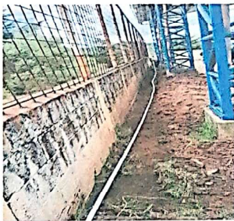
Foto 5: Minstalación agua potable
