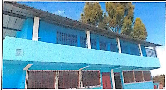
SUMINISTRO DE BALCONES METALICOS EN PASILLO SEGUNDO NIVEL
