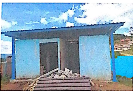
Foto 5: Suministro e instalación de estructura metálica y cubierta de lámina para techo en módulo de 4 sanitarios
