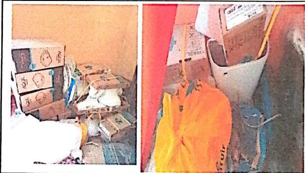
Foto 4: Suministro de material de 4 inodoros y 4 lavamanos
